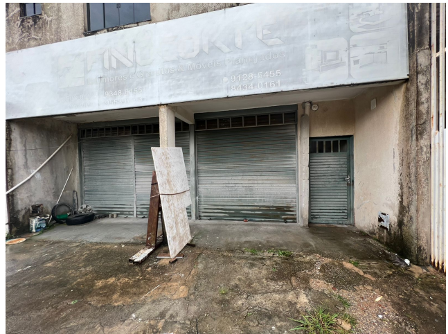
Fotografia 2 - Vista de acesso ao imóvel.
