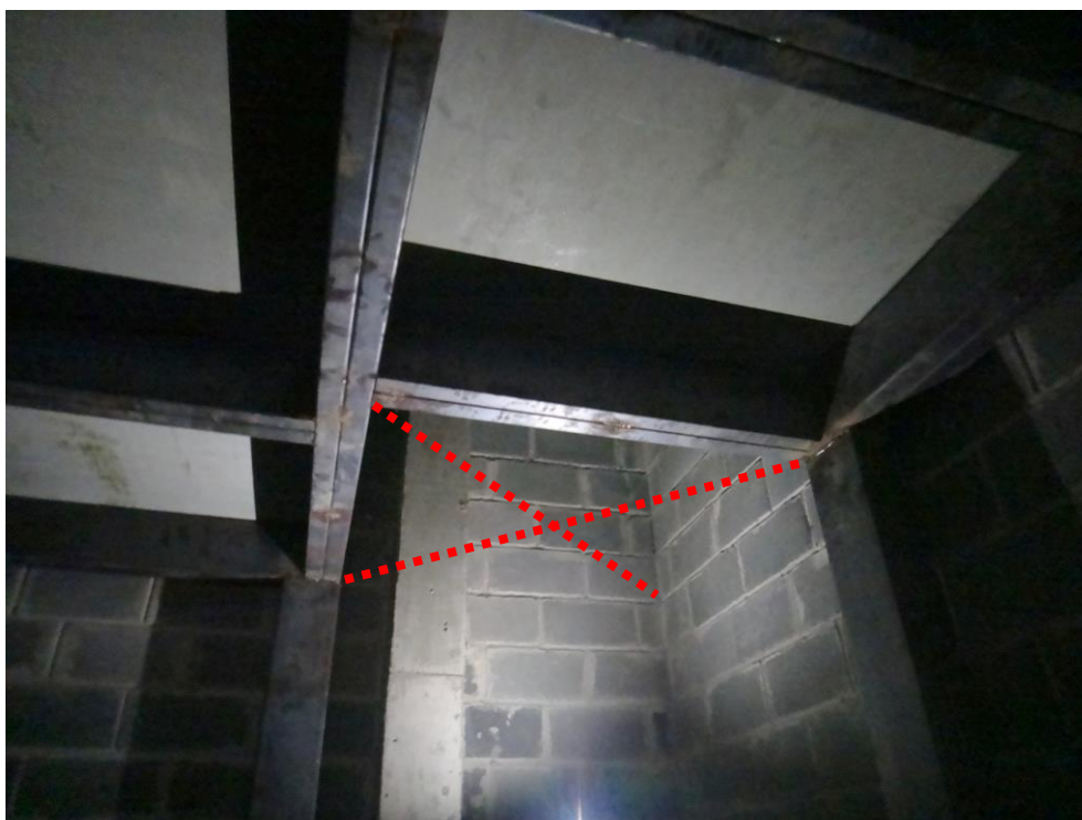
Foto 6 – Vão para instalação de escada e acesso ao mezanino
