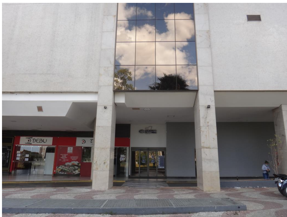
Foto 2 – Acesso 2 ao Shopping Center
