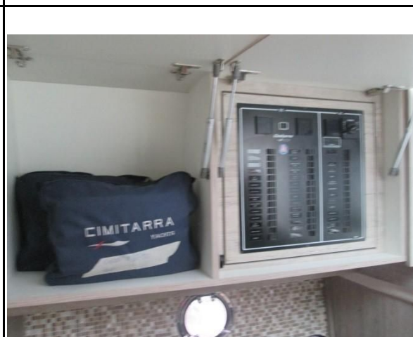
22. Armário com bolsa de Manuais e Documentos e Painel Elétrico
